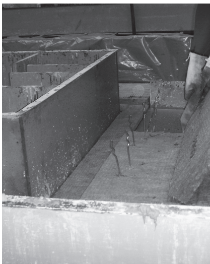
Einbau im Fertigteilwerk: SPA-A
